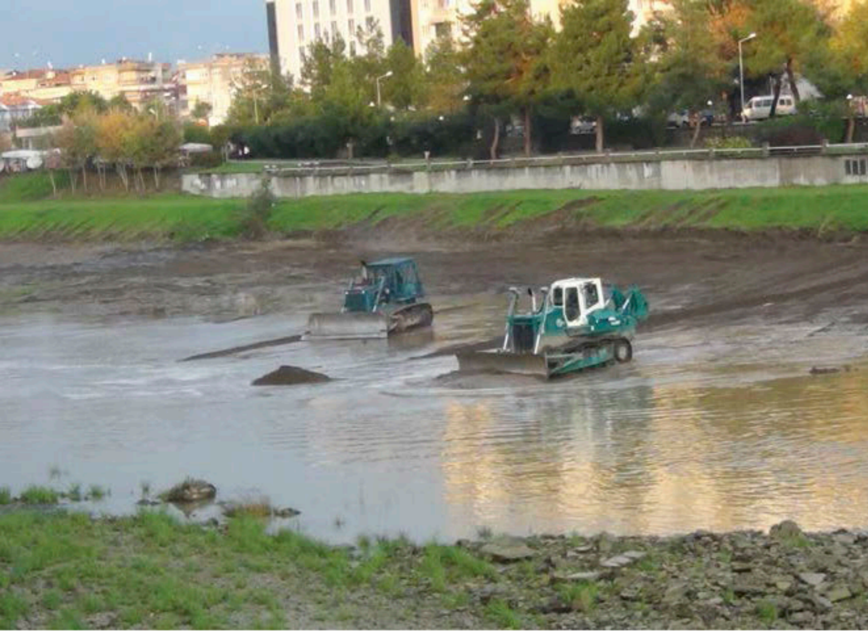
Fotoğraf 9.12. Nehir yataklarında akıntılarla birlikte oluşan kum birikintilerinin, adacıkların DSİ tarafından temizlenmesi. Kızılırmak ve Yeşilirmak üzerinde yüzyıllardır devam eden bu oluşumlar bir dönem Kızılırmak ağzında Mersin balıkçılığı için bir sorun olarak görülmekteydi. Aynı zamanda Kızılırmak ve Yeşilirmak nehirleri üzerinde yıllardır hayal edilen nehir taşımacılığının bir türlü hayata geçirilememesi problemi de bundan kaynaklanıyordu. Fotoğrafta görülen çalışmada, 2015 yılında Yeşilirmak'ın Çarşamba şehir merkezinden geçtiği güzergâhta DSİ tarafından Yeşilirmak nehir tabanı düzenleme çalışması görülmektedir.
